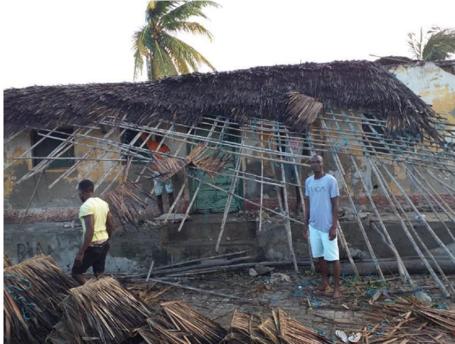
Figura 3. Moradores da Ilha de Moçambique recuperando a cobertura de uma casa destruída pelo ciclone Gombe, em 2022.
