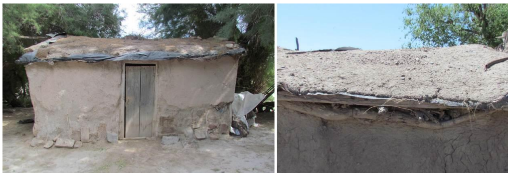
Figura 13. Cubiertas de torteado sobre cañas con film de polietileno.
