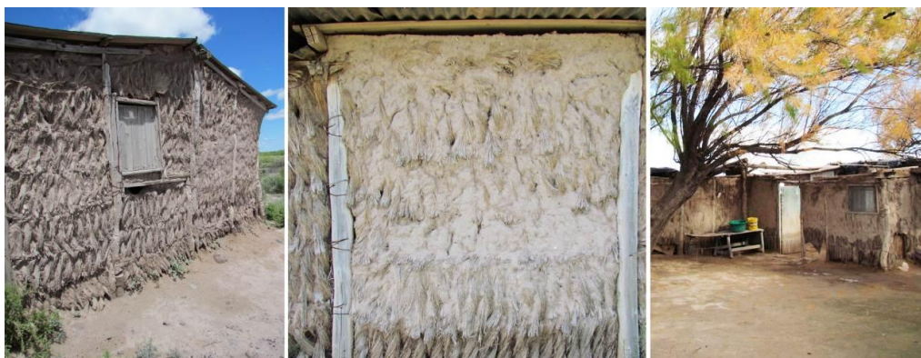
Figura 10. Envolventes de chorizo a las que se le han lavado los revoques. Fuente: Fotografías tomadas por la autora en 2019 y 2021.
