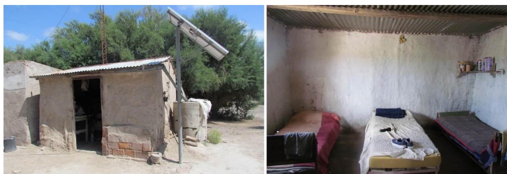
Figura 11. Revoques de tierra en casas de la zona de Paso de los Algarrobos y Paso Maroma
