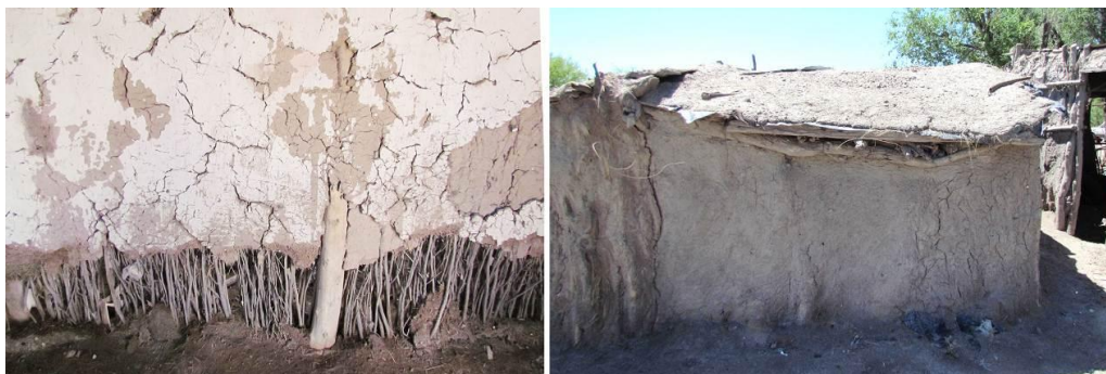
Figura 6. Cerramientos construidos con jarilla embarrada.
