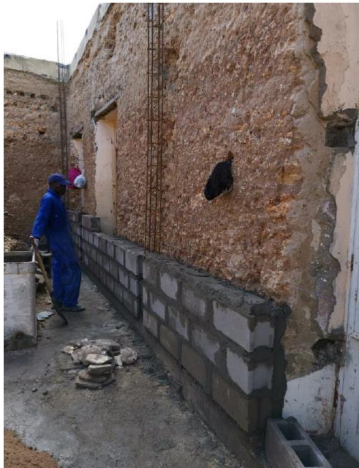
Figura 5. Construção de paredes de blocos de cimento dentro de um antigo armazém na Ilha de Moçambique. Fonte: Didi (2019, p. 82).
