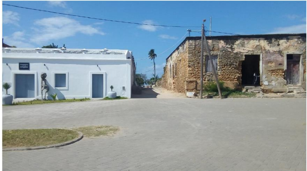
Figura 4. Rua que separa a Cidade de Pedra e Cal, à esquerda, e a cidade de Macuti, a ruína do antigo mercado de escravos, hoje ocupado por algumas famílias, à direita. Fonte: Paiva (2024, p. 11).
