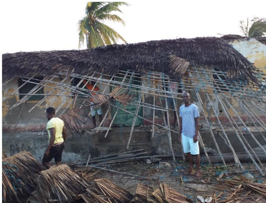
Figura 3. Moradores da Ilha de Moçambique recuperando a cobertura de uma casa destruída pelo ciclone Gombe, em 2022.
