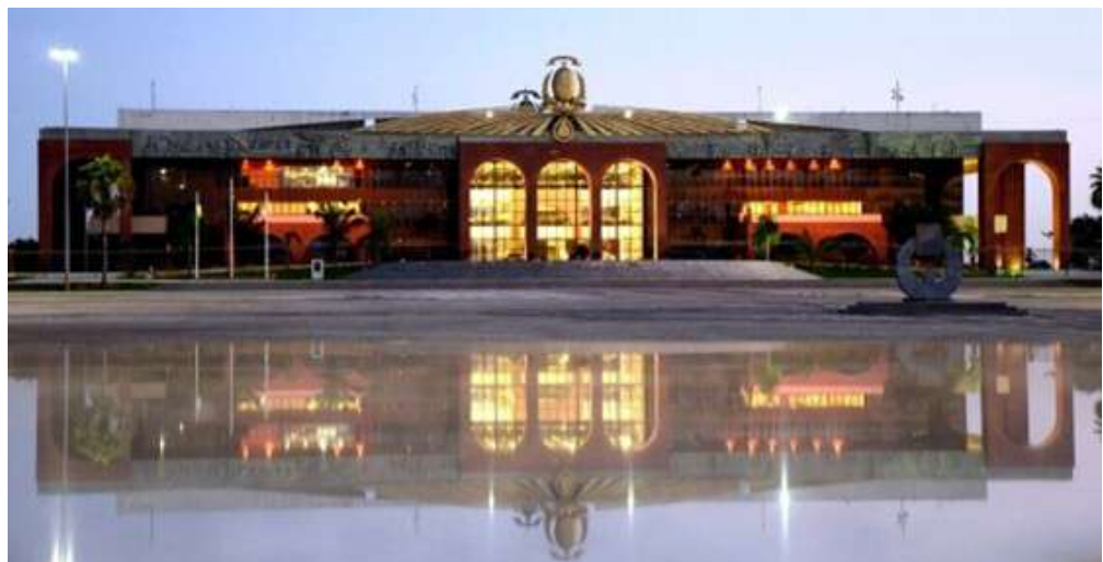
Figura 2. Palmas. Edifício Monumental do Palácio Araguaia Governador José Wilson Siqueira Campos. Fonte: Márcio Vieira/Secom. Acervo arquivo público da Secretaria de Comunicação do Estado do Tocantins.
