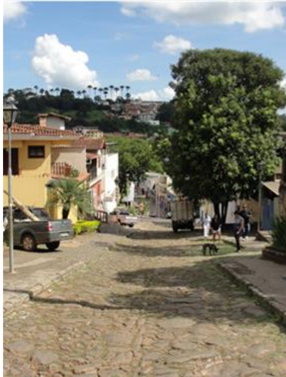
Figura 6: Pavimentação em dias atuais da rua Padre João Pio, com calçamento pé-de-moleque Fonte: Elaborada pelos autores, 2015.
