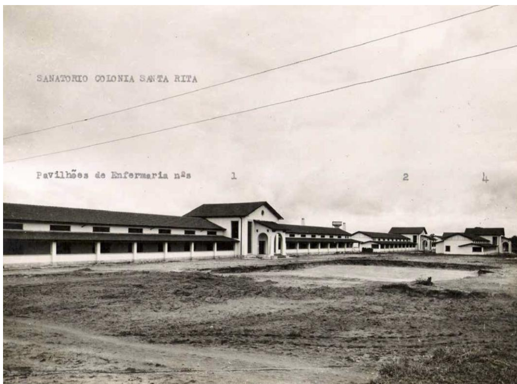
Figura 1. Sanatório Colônia durante sua construção na década de 1940/1950. Fonte: AEP (2013). Catálogo.
