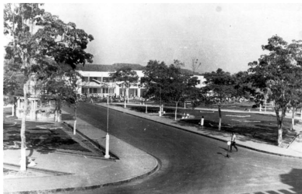
Figura 3: Antiga Praça Plácida de Castro na década de 60, com destaque para a alameda de veículos fragmentando o espaço.
