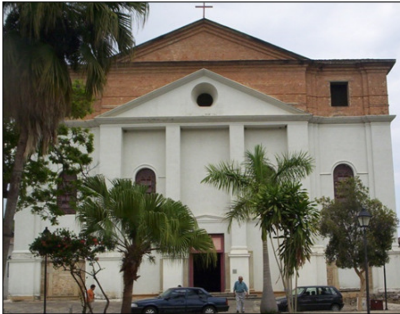
Figura 1 – Matriz de Santana na Cidade de Goiás - A aparência “inacabada” da Igreja foi inspirada na sua longa história de desabamentos e reconstrução
